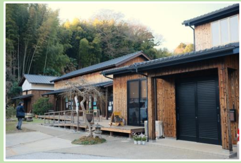
施設の整備(改修)
