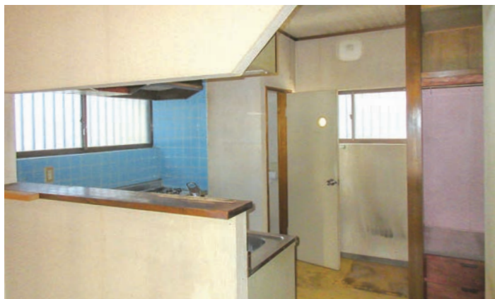
リフォーム前の住宅 2階にあったキッチンが1階に設置予定
